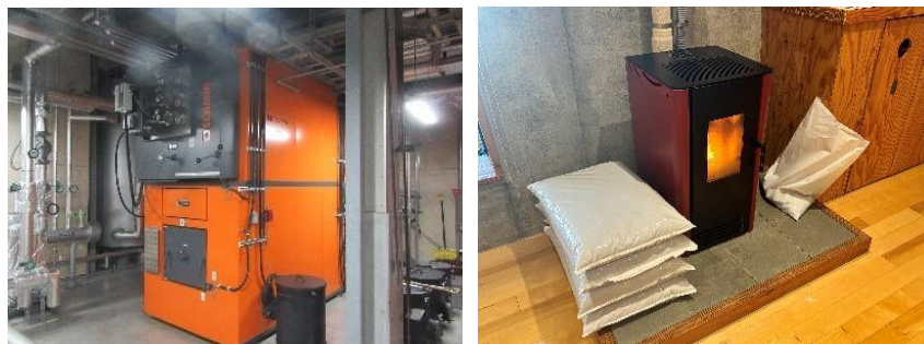
写真3 木質バイオマスボイラー(下川町、左)と木質ペレットストーブ(津別町役場、右)
