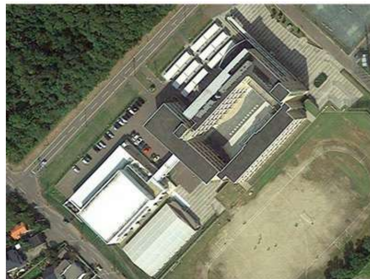
図 岩内高校屋上における太陽光発電設備
