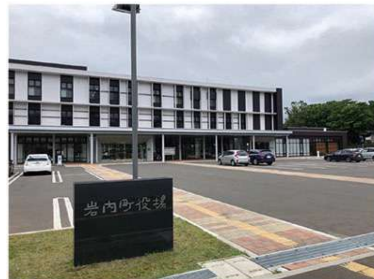
図 岩内町役場外観写真
