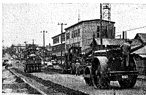
町道を舗装中 (清住地区)
