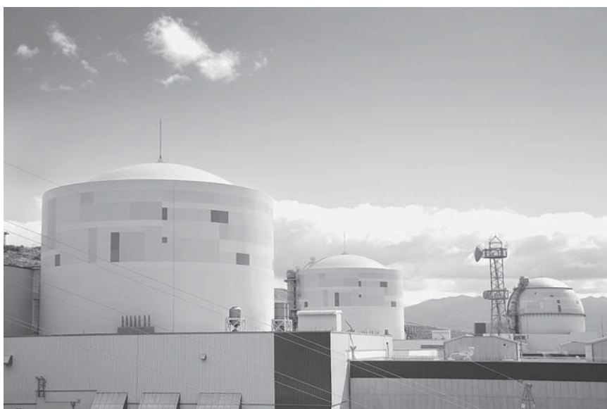
泊原子力発電所
